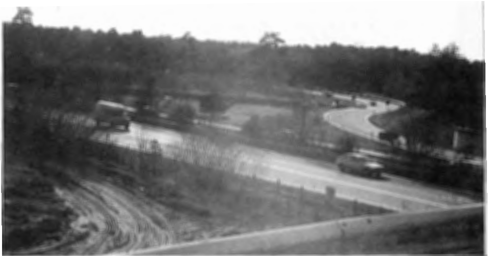
Abb. 23: Blick auf die Autobahn A 643 und den Autobahnzubringer auf der Höhe von Gonsenheim bzw. Mombach. April 1987.
